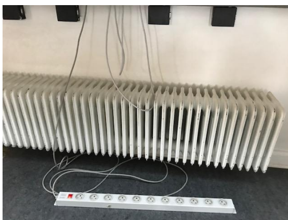
Fig.21. Løs strømskinne, som burde fastmonteres på fx bord eller væg ved bord.
