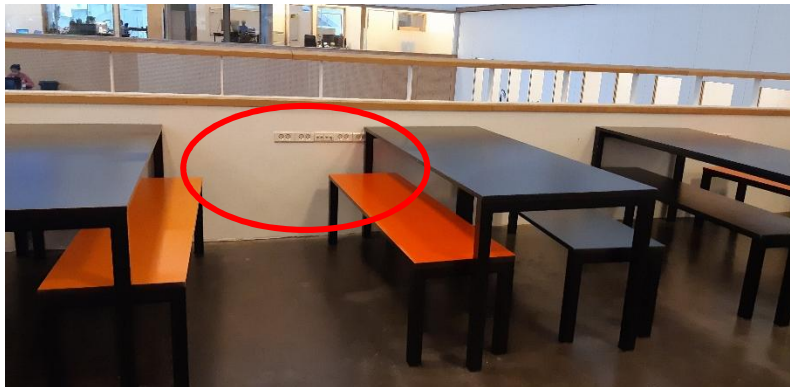
Fig. 18. Fin løsning med strøm i væg.
