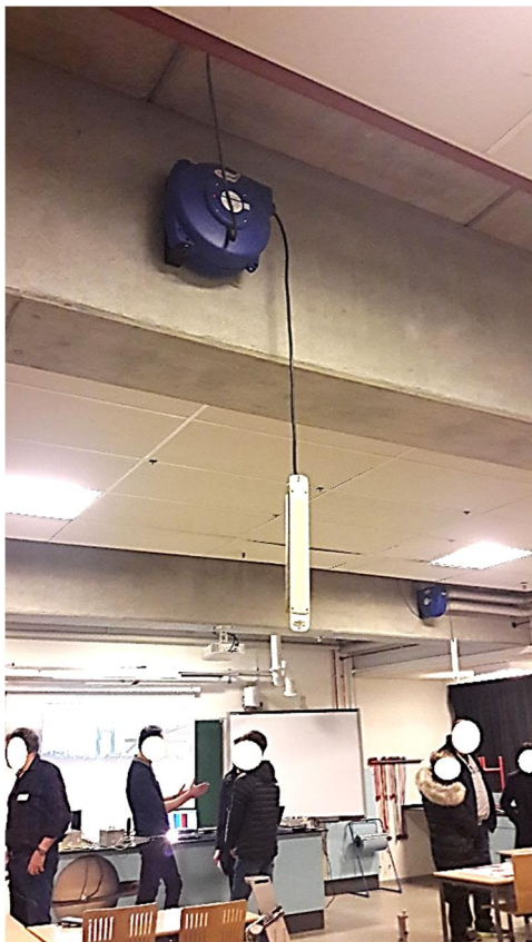
Fig. 14. Hvis loftkonstruktionen tillader det, kan man montere en kabel-jo-jo med en stikdåse, der kan trækkes ned efter behov. Ingen snublefare og mere tilgængeligt for rengøringen.
