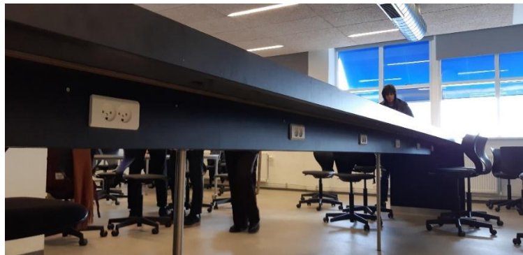
Fig. 10. Strømuttag under bordpladen øger risikoen for at tilsluttede apparater trækkes ned på gulvet.
