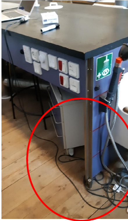
Fig.9. Lærer-PC tilsluttet smartboard med kabel. Kablet ligger i ganglinjen. En mere permanent løsning med kabelbakke på gulvet – eller placering af PC ved smartboard ville være bedre.
